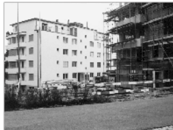
Die von der «GWS» im äusseren Rünenfeld erstellten 110 Wohnungen können als Wohneigentum erworben werden.
