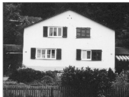
Die «GEWOBAG» ist die Erbauerin einer ganzen Serie von 18 solchen Zweifamilienhäusern an der Oberlandstrasse. (Erbaut 1947)
