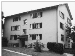
Die «Baugenossenschaft Schönheim» baute im Jahre 1950 dieses Sechsfamilienhaus an der Winterthurerstrasse.
