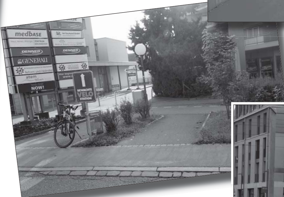
Der Übergang Oberlandstrasse-Breitackerweg: Der Veloweg ist «gedacht» erkennbar, doch Büsche versperren die Sicht, Pfosten verengen den Veloweg.
