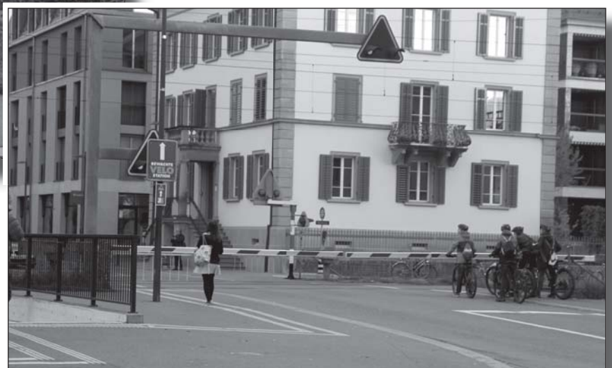
Geschlossene Barrieren sind auch für Velofahrende ein Problem. Fussgänger- und Velo- unterführungen könnten das Problem beheben.
