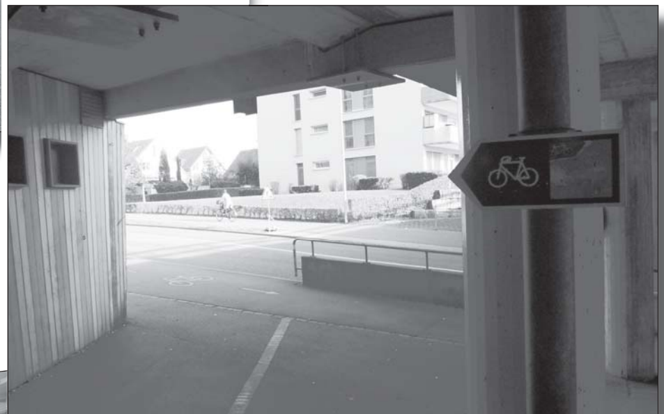
Die Unterführung unter der Haupt-sammelstelle an der Dammstrasse: Die Sicht ist behindert, es besteht Kollisionsgefahr. Und rechts abbiegen ist nicht erlaubt. Warum?
